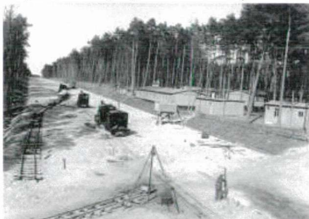
4. ábra. Betonburkolatú autópálya építés Németországban a 30-as években Figure 4. Concrete highway construction in Germany in the '30-s
