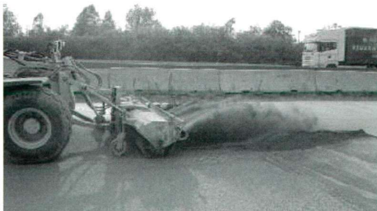
6. ábra. Felületképzés a mosott betonburkolatú szakaszon Figure 6. Finishing the exposed-aggregate concrete pavement
