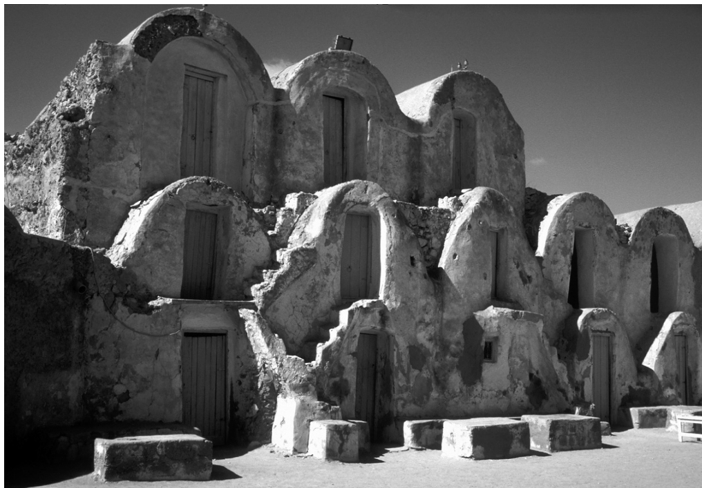
Gorfák a dél-tunéziai Medenine-ben. A gorfa gabonátároló kamrát jelent, melyeket a képen látható módon építenek egymás mellé és fölé. Medenine egyik nevezetessége, hogy a városban forgatták a Star Wars című film első részét 1999-ben ❖ Fotó: Karancsi Zoltán
