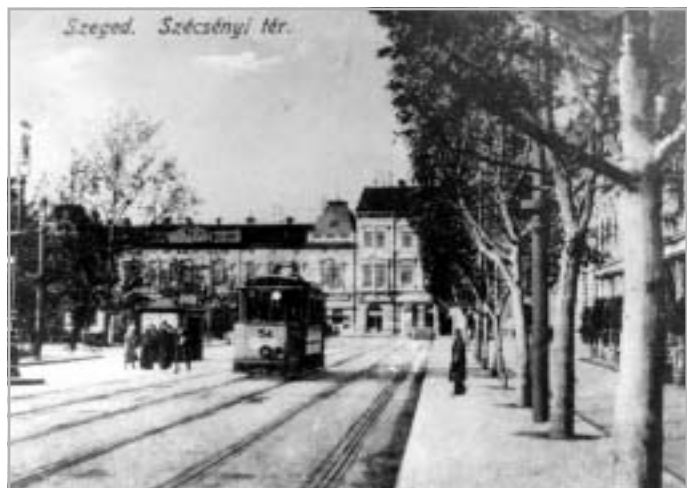
8. ÁBRA A SZÉCHENYI TÉRI VILLAMOSVÁGÁNYOK A VÁRÓHELYISÉGGEL ÉS AZ 54. SZÁMÚ VILLAMOSKOCSIVAL. AZ SZKV AZ EREDETELEG ZÁRT SZEKRENYŰ PÓTKOCSIT A KKM 87886/1910. SZ. ENGEDÉLYE ALAPJÁN MOTORKOCSIVÁ ÉPÍTETTE ÁT
