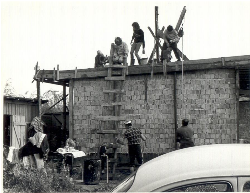
5. kép: Tetőbetonozás (Puskás Vilmos felvétele)
