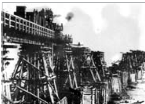
12. ÁBRA A VASÚTI FAHÍD BONTÁS, KÖZBEN
