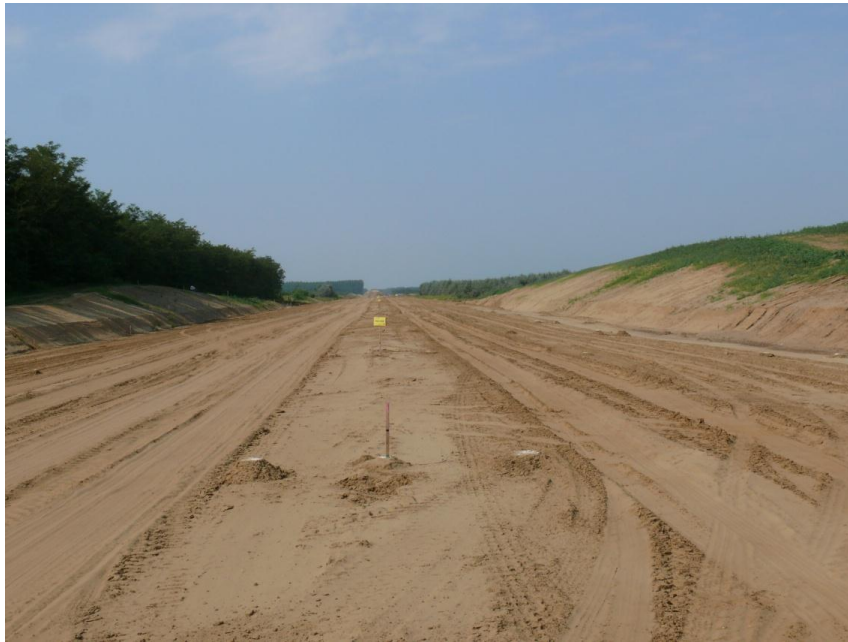
15. ábra Útbevágás az M3-as autópálya építésénél
