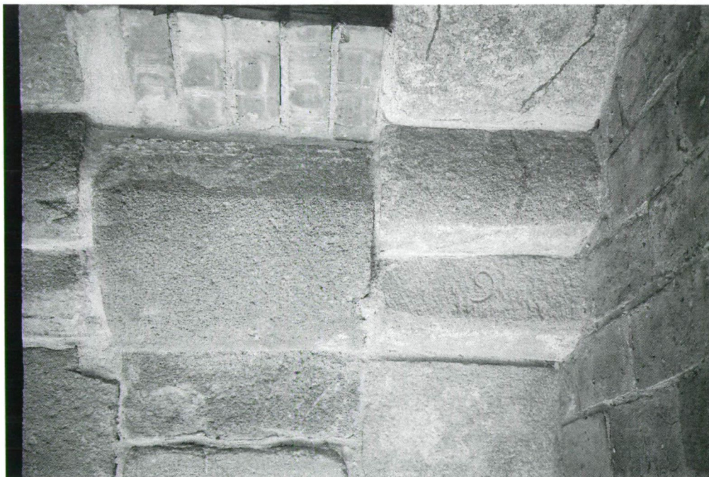
5. ábra: G mesterjegy az alsóvárosi templom ablakkváderét adó bózesi hommokövön utalva a kőfaragó származási helyére (Gyulafehérvár) Fig. 5. Initial G on the „Bózes” type sandstone rock forming the window arch of the Downtown church, Szeged indicating the origin of the carver (Alba Iulia-originally Gyulafehérvár)
