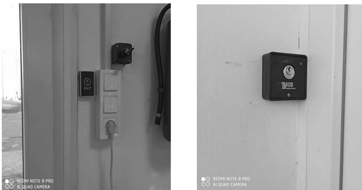
1. ábra: Közelítés érzékelő és kulcsos kapcsoló felszerelve, bekötve
