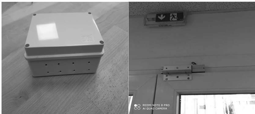
3. ábra: A vezérlő egység doboza, ajtótartó mágnes felszerelve
